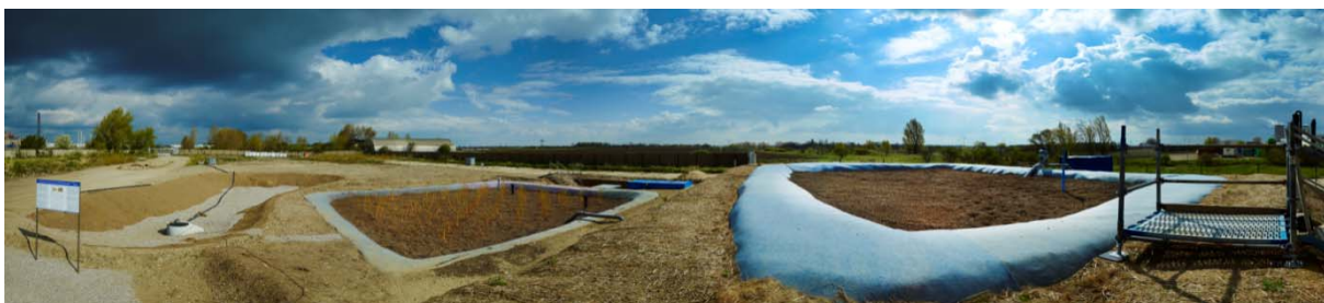
Abbildung 27: COTRA-Pilotanlage am Chemiestandort Leuna
