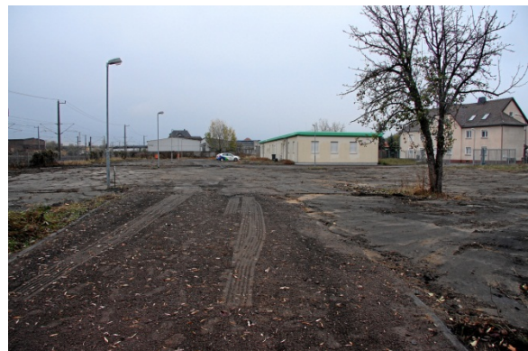
Abbildung 32: SAFIRA-Gelände nach Rückbau der Pilotanlage
